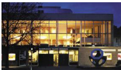
Vor dem Umbau 2009 Mainfranken Theater
